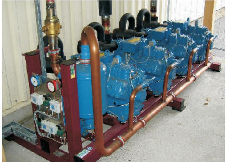
Abbildung 4: Größere Kälteanlagen werden mit mehreren Verdichtern ausgerüstet
