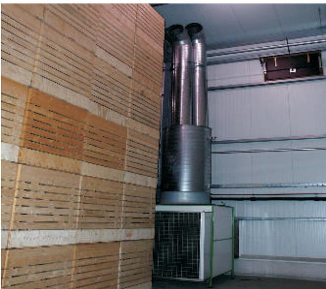
Abbildung 2: Bei der Kistenraumbelüftung umströmt die eingeblasene Luft die offenen Großkisten
