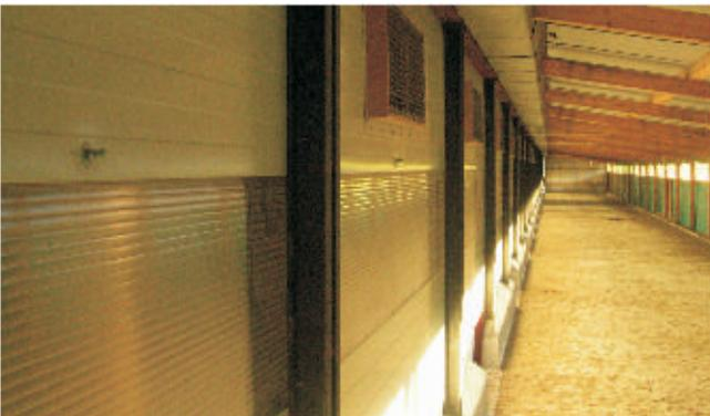
Der alte Wandaufbau wurde demontiert und gegen Sandwichpanellen ersetzt
