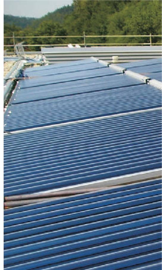
Solarthermische Anlagen werden bisher in Deutschland überwiegend zur Brauchwassererwärmung eingesetzt. Eine Nutzungsform der Sonnenenergie, die insbesondere für Betriebe mit hohem Saisonarbeitskräfteeinsatz interessant ist, da hier in den Monaten hoher Sonnenenergieeinstrahlung ein erhöhter Brauchwasserbedarf besteht.
